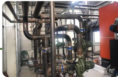
Kasvihuoneen lämmittämiseen käytetään uusiutuvaa energiaa.
