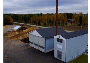
Kuva: Pohjanmaan Biolämpö Oy
