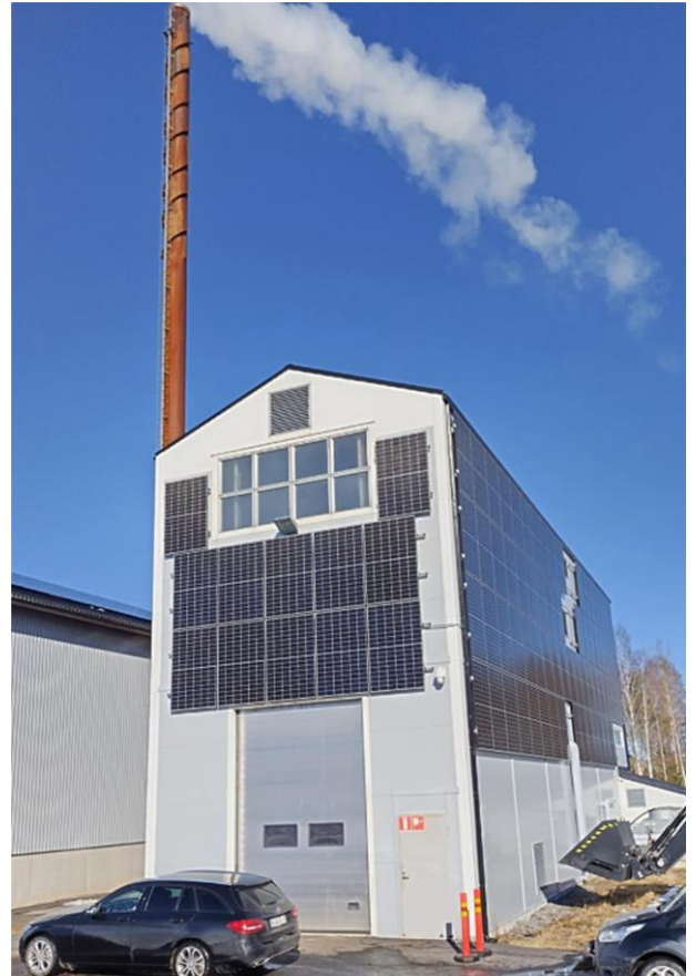
Kuva: Pohjanmaan Biolämpö Oy
